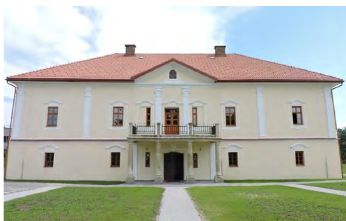
Rekonštruovaný kaštieľ v roku 2015
